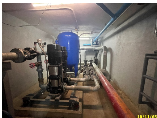
เครื่องปั๊มน้ำ และถังเก็บน้ำชั้นดาดฟ้า
